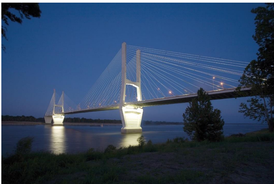
ST 社が建設に関わったグリーンビル橋
